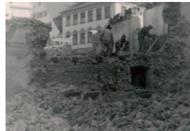
Arbeiter beim Abbruch des „Schatten“ 1938
