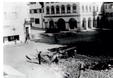
Grube nach Abbruch, heute Kornhausplatz
